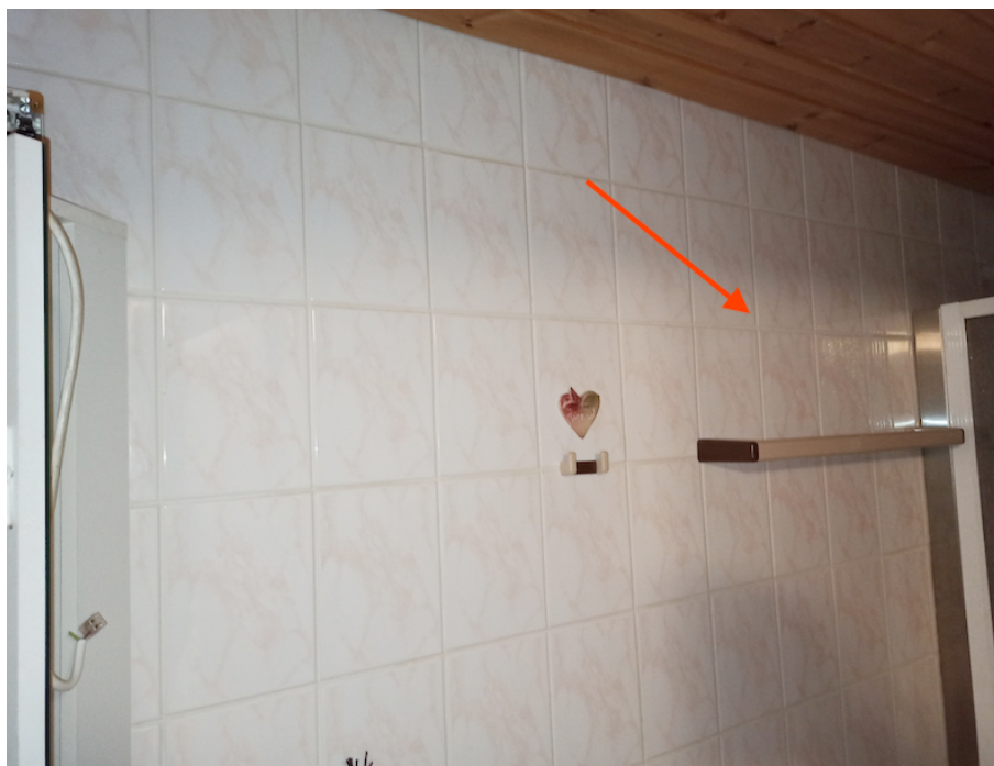
Kuva 8, vanhan valaisimen asennuskohta.
