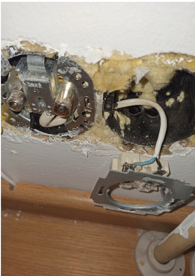
Kuva 22, takkahuoneen pistorasian kytkentä kalustejohdolla.
