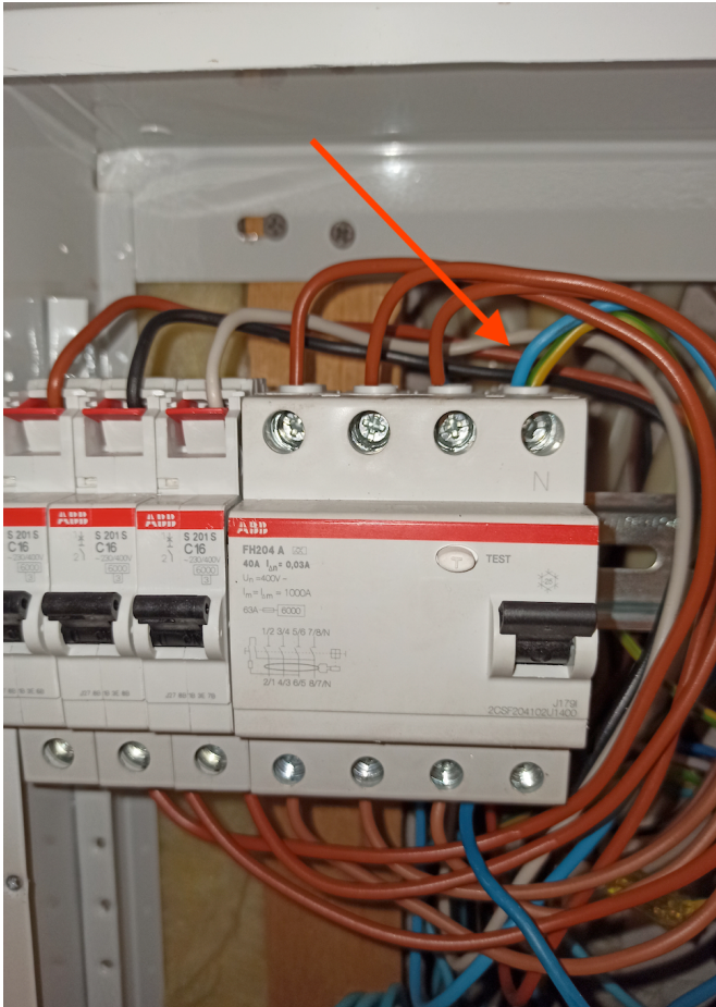
Kuva 2, VVS asennusvirhe
