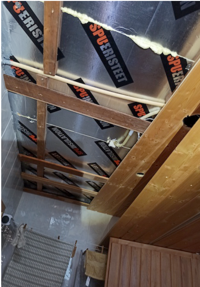
Kuva 15, katon aukaisu pesuhuoneessa.
