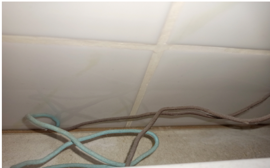
Kuva 22, WC valaisimen johtimet seinän ja peilikaapin välissä
