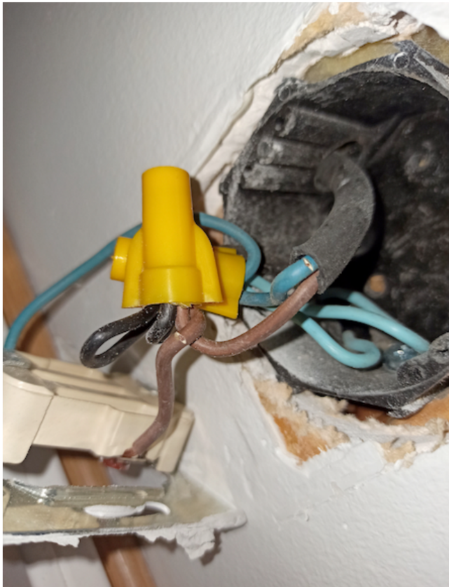
Kuva 28, olohuoneen pistorasian kytkentä.
