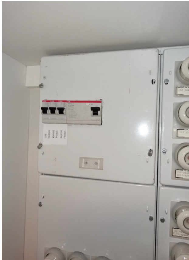
Kuva 1, Lisätty vikavirtasuojakytkin.
