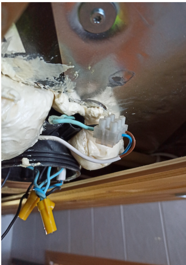
Kuva 17, halogenmuuntaja välitilassa. Hyvien asennustapojen vastainen
