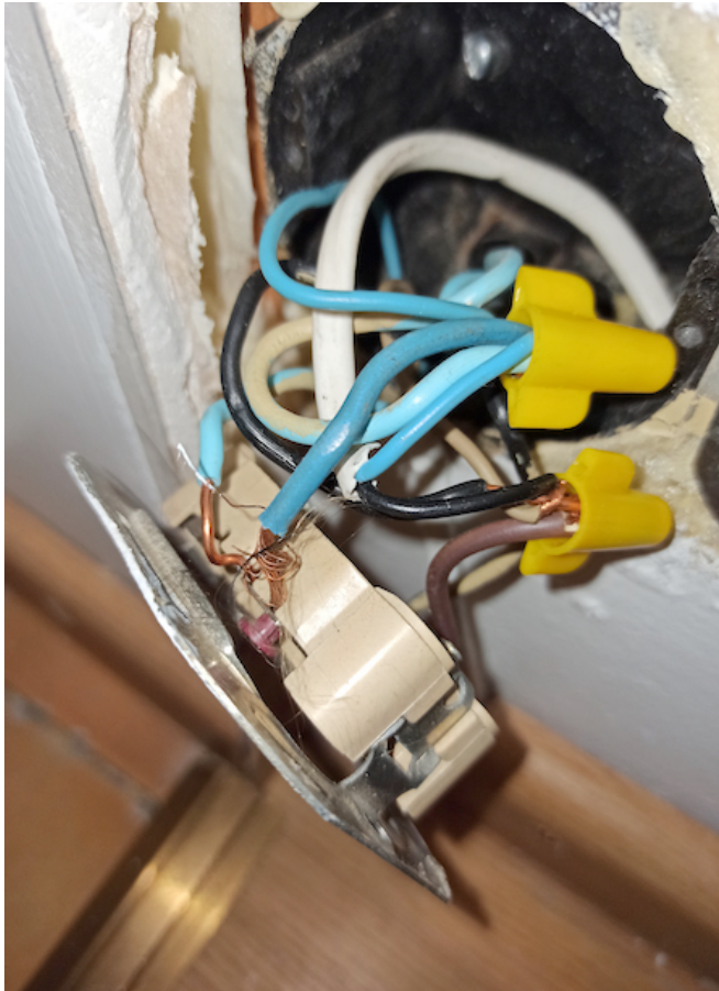
Kuva 21, takkahuoneen pistorasiakytkentä.
