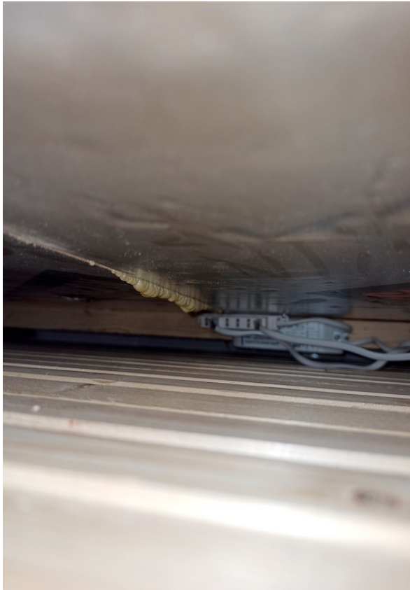
Kuva 17, halogenmuuntaja välitilassa. Hyvien asennustapojen vastainen
