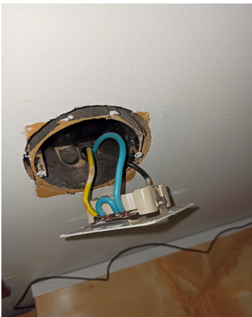
Kuva 3, sininen johdinlenkki nolla- ja suojajohtimen välillä.
